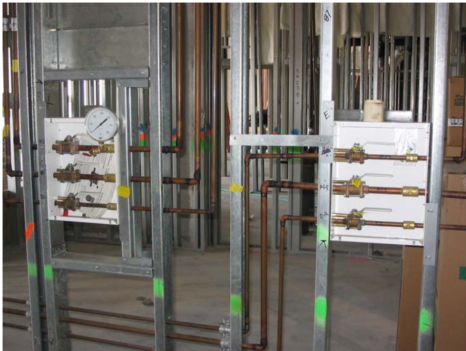
Med Gas Shutoff Valves
